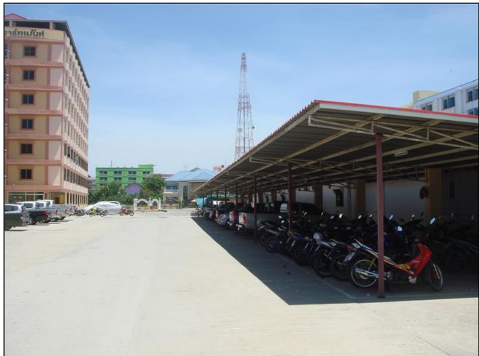
สถานที่จอดรถ ชลอ เฉลิมชัย อพาร์ทเมนท์
