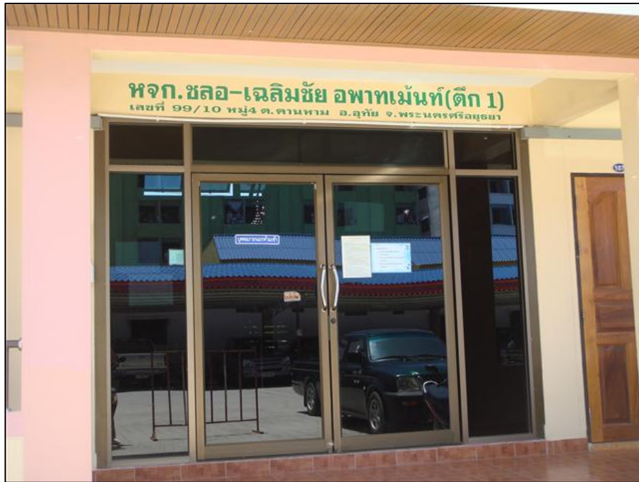
สำนักงาน ชลอ เฉลิมชัย อพาร์ทเมนต์
