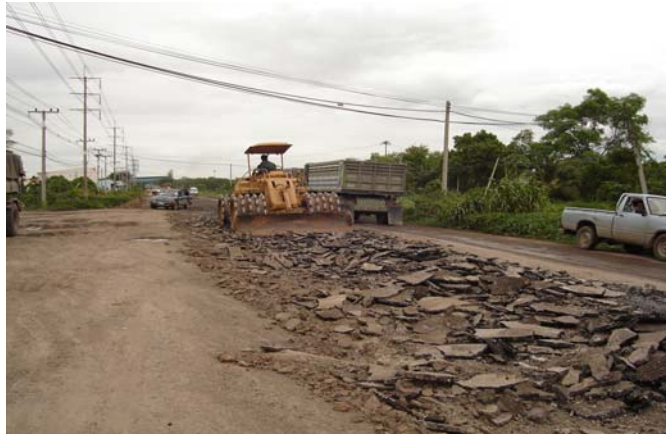
ภาพประกอบ 19 การรื้อชั้นงานถนนเดิมที่มีคุณสมบัติไม่ดีออก
