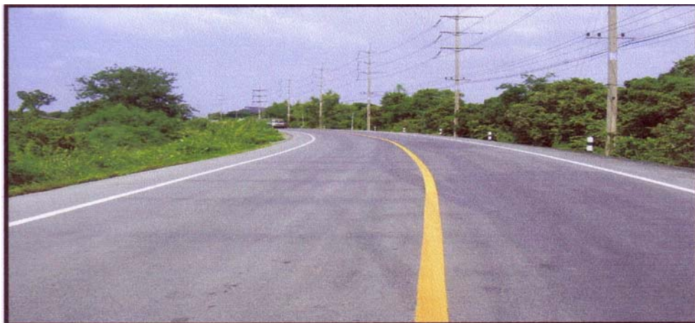
ภาพประกอบ 18 ภาพถ่ายเส้นทางสายแยกทางหลวงหมายเลข 32 (แยก กม.ที่ 79+000) ที่ก่อสร้างปรับปรุงเสร็จ
